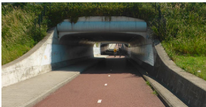
Eisenhowerův tunel na cyklistické dálnici F325 v Holandsku. Příímý vjezd, dobrá dohledová vzdálenost i světlovody v dalších částech tunelu [5]
